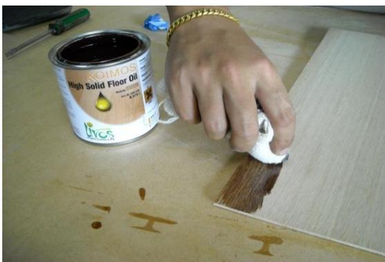
小面積用軟布(或橡皮刮刀)，大面積採用刷子或短毛滾輪依木紋方向塗佈，沾油均勻"薄"塗於木料表面後，靜置 5~10 或 20 分鐘(視現場溫度而定)，再以刷子推開多餘的護木油，以利木料均勻吸收。
