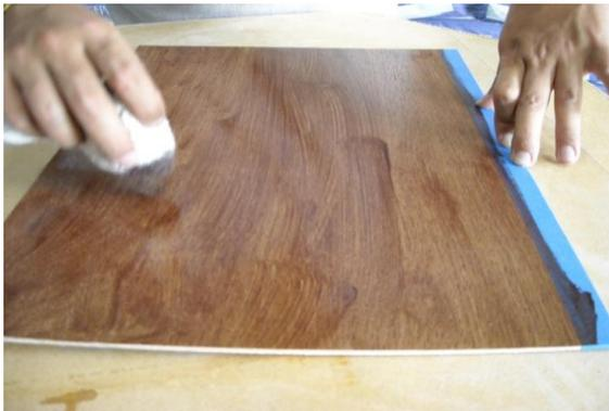
距第一度推勻後約靜置 18 小時(視現場溫度而定),並觀察第一度完全乾燥後,即可進行第二、三度的磨光,視木材吸收度,以刷子塗佈適量之護木油,待木材吸收 5~10 分鐘後,以乾淨的軟布將表面多餘護木油擦拭掉即可。
